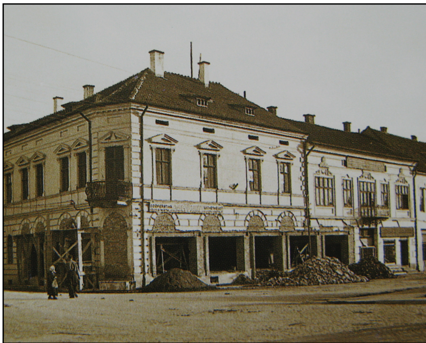
A fenti két fotó azt mutatja be, amint a két ház közötti tűzfal felszámolásával -és nagy statikai erőfeszítéssel- a földszinti kirakatok szintjén egybeolvad a két ház.
