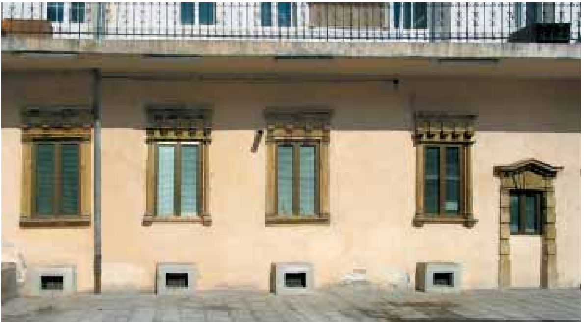
36. Az udvari homlokzat részlete
