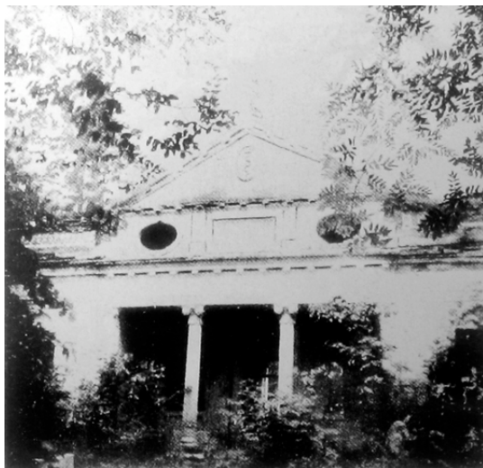
101. kép. A kerlési Bethlen-kastély északi homlokzata. (A szerző felv.)
