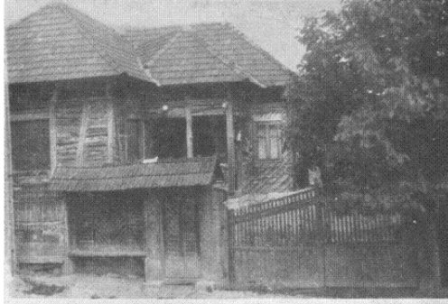
120. Épülő faház, szakállszárító faragott kiskapu
