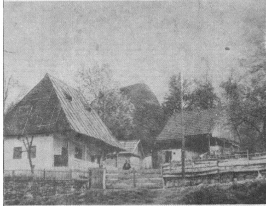
122—123. 1—2. A zsindeletetőt Som- telkén (122) és Mogyorókerekén (123) is a cserép (néha kátránypapír) vál- totta fel
