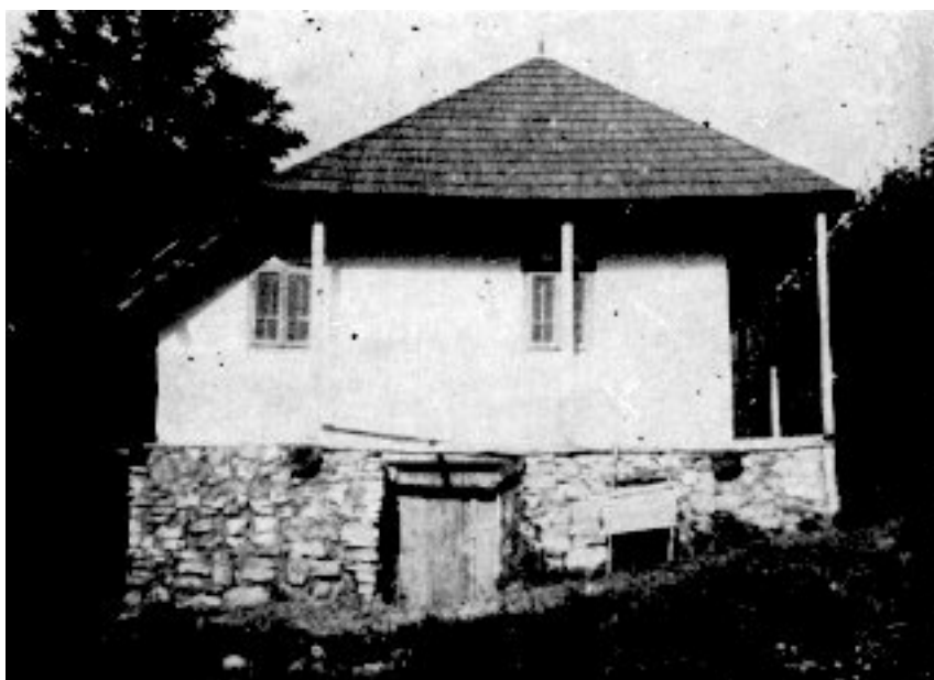
16. Bece Antal alul pincével, hátul kilérrel, széles töltéssel, zsindelytetővel épült új háza (oldalsó homlokzat), Bf.
