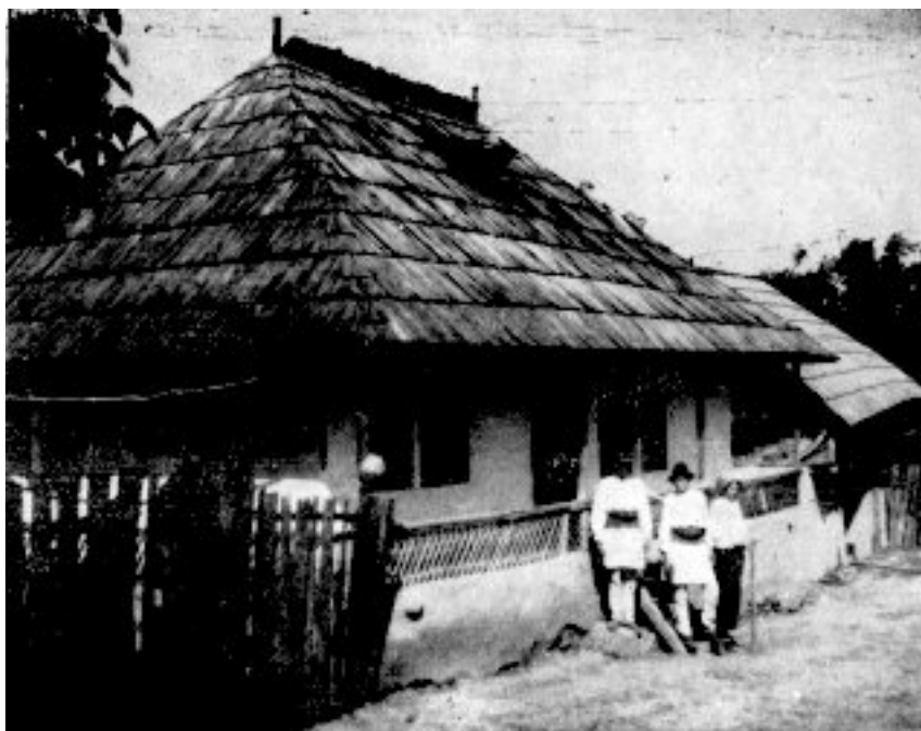
15. Kétszobás, tornácos, zsindelyezett tetejű ház, Bf.
