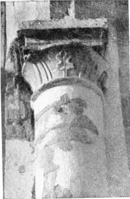
10. kép. A diadalív északi pillérfejezete homloknézetben
