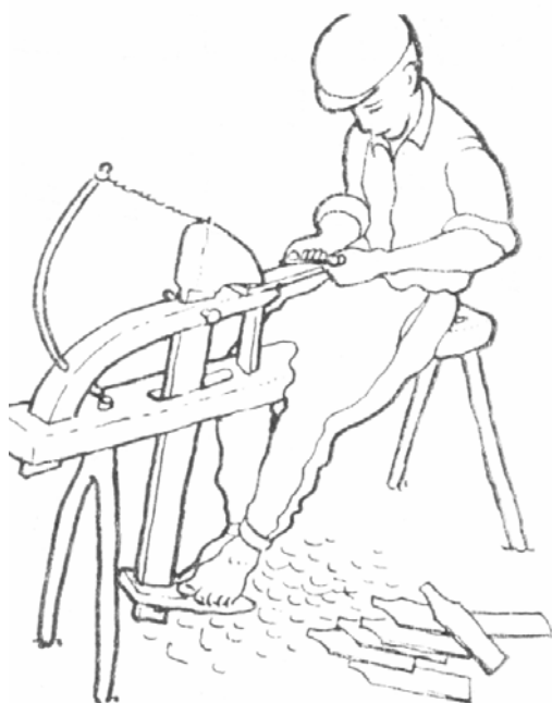
39. Endelyvágó. A Csíkból vagy Caşin-völgyi falvakból hozott zsendelyt somfa árkkal (íj) felszerelt faragószéken metszették.
