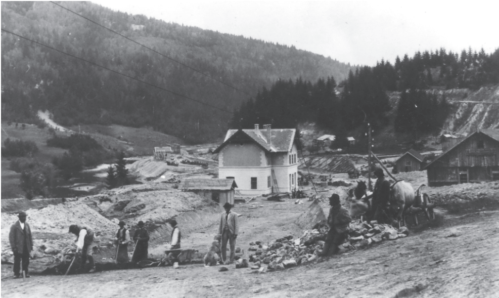
19. ábra. A Sepsiszentgyörgy–Csíkszereda vasút építése tusnádfürdőnél, 1896-ban. 407
