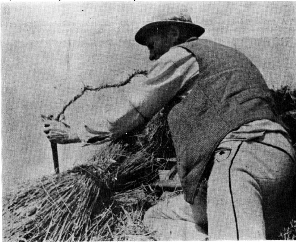
45. A tetősík első zsúpjának felvarrása szimpla fedélen (a zsúp kalászos végével lefelé): a mester a zsúpvarrótűt beledöfi a zsúpba
