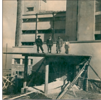
Építkezés a csíkszentsimoni keményítőgyárnál (Lakatos András tulajdon.)
