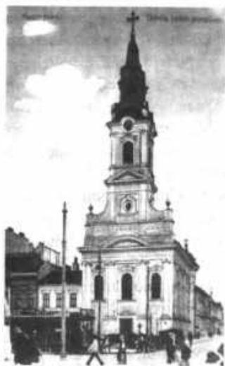
A Holdas templom főhomlokzata
