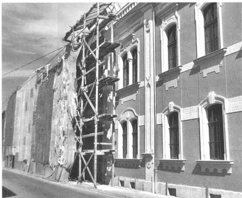
Felújítás alatt a homlokzat – 2014
