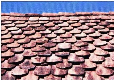
5. kép: Az épületek nagy részét már a XIX. században helyben vetett cseréppel fedték
