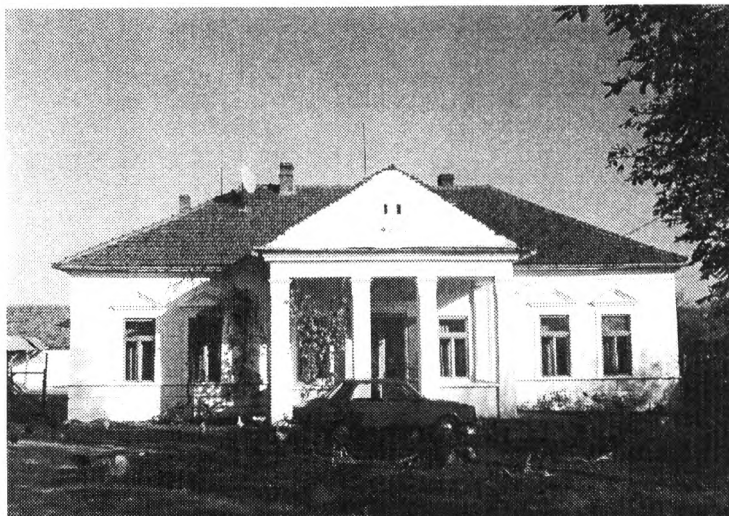
A szilágynagyfalusi Állatorvosi Hivatal épülete
